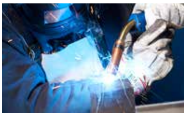
Наплавка металла на повреждённый инструмент (MAG-сварка)
